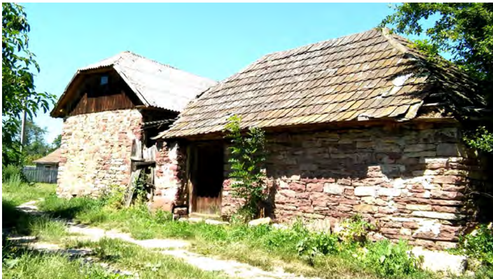
Рис. 13. Господарські будівлі (с. Нирків).
