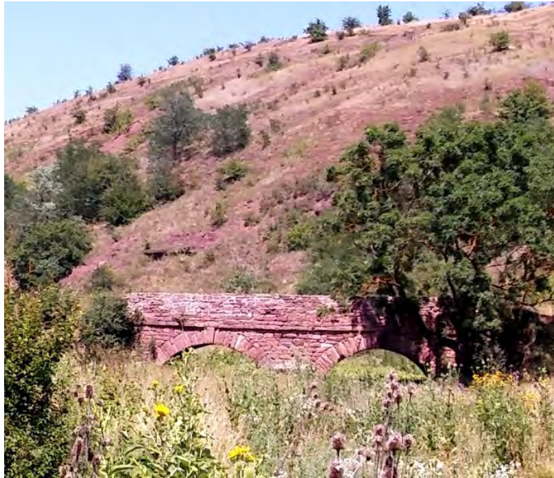
Рис. 12. Міст на замковій дорозі через р. Джурин.
