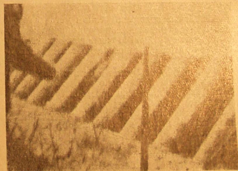
Батерія метачів Лівенса на боєвім становищі — Метачі вкопують в землю під кутом 45°, один коло одного, полученні в батерії по 25-50 штук. Газові міни вкладають згори, щоб опиралися об ладунки вибухового матеріалу в рурі і запалюють електричним током. Після вистрілу метачі зрушуються і розкидаються; до наступного мету треба їх наново уставити.
